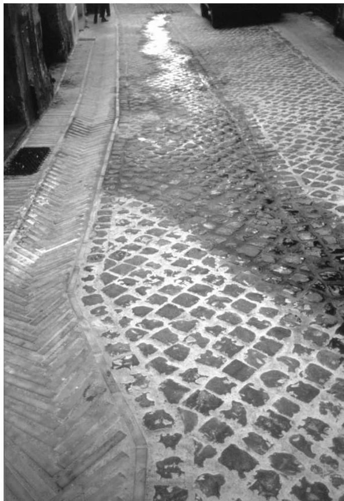
*Esempio tra i numerosissimi dovuti alla volontà di “rinnovamento”, uno dei casi di perdita definitiva delle pavimentazioni ottocentesche rintracciate sotto lo strato di asfalto e rimosse con grande disinvoltura e sostituite da una nuova pavimentazione con innesti in cotto con conseguente perdita definitiva di un elemento di importanza storica ed estetica dell'insediamento.*
